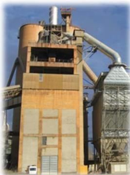
En el enfriador de clínker hay instalado un electrofiltro, y en el molino de combustible, molinos de cemento y en las ensacadoras, hay filtros de mangas que permiten reducir sustancialmente la carga de partículas.
